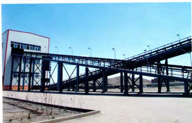
黑鹰山矿区百万吨贫矿选矿厂生产线
