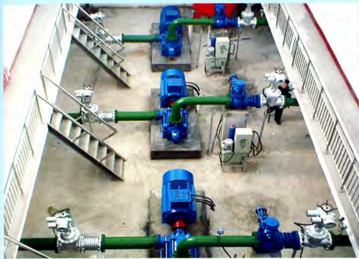
30年大庆献礼工程即巴彦浩特新井水源地供水工程二泵站泵房
