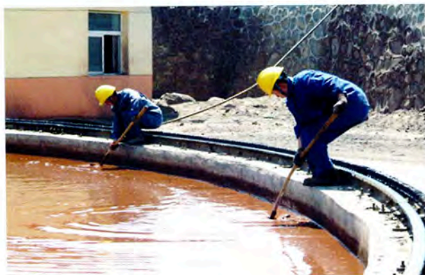
额济纳旗黑鹰山矿区百万吨贫矿选矿厂浓缩池
